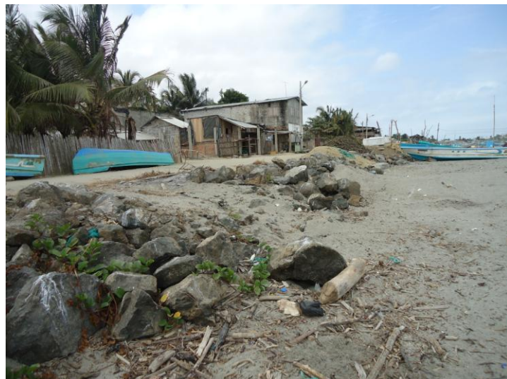
Foto 16.- Por la acumulación de arena, el enrocado podría estar actuando como una rampa
