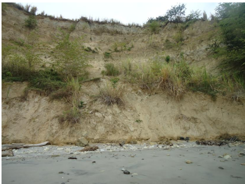
Foto 23.- Deslizamiento de la parte superior del acantilado
