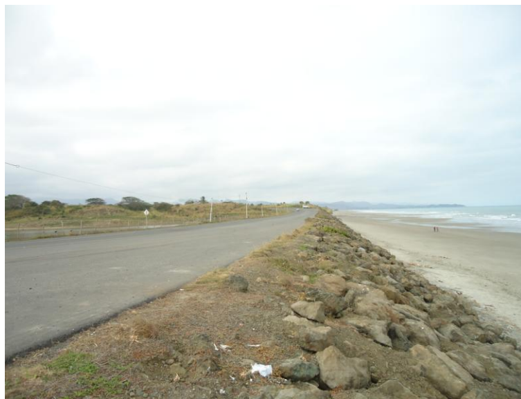
Foto 3.- Muro de contención construido para proteger la carretera del choque de las olas
