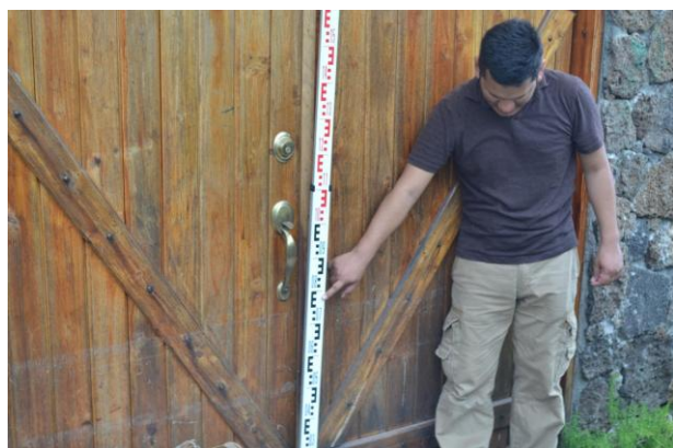
Figura 26 Daños producidos por el impacto de las olas, en la ruta a Punta Estrada.
